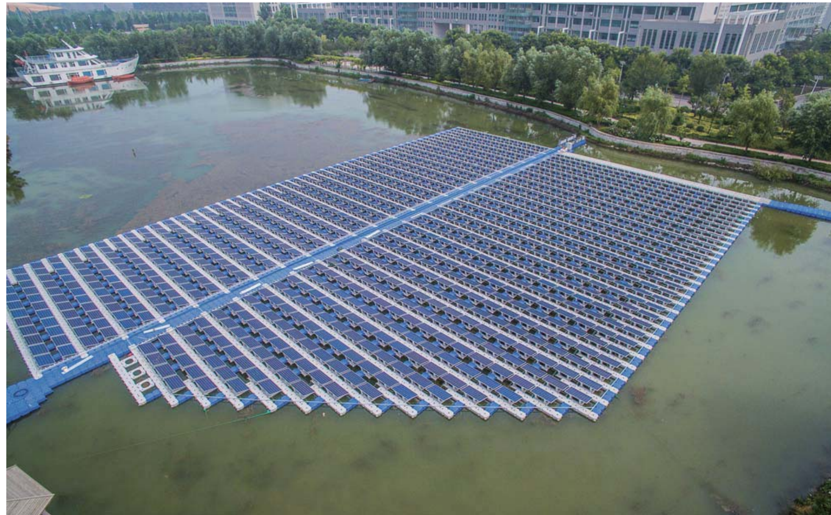
晶科科技山东济宁300千瓦水面漂浮分布式光伏电站
