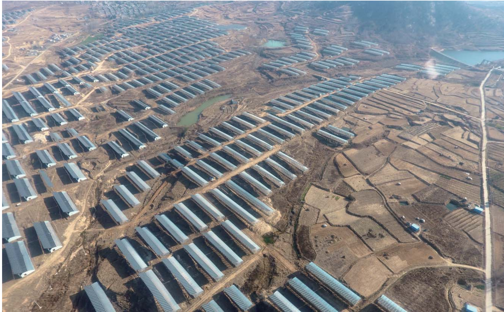
山东新泰采煤沉陷区国家先进技术光伏示范基地100兆瓦项目
