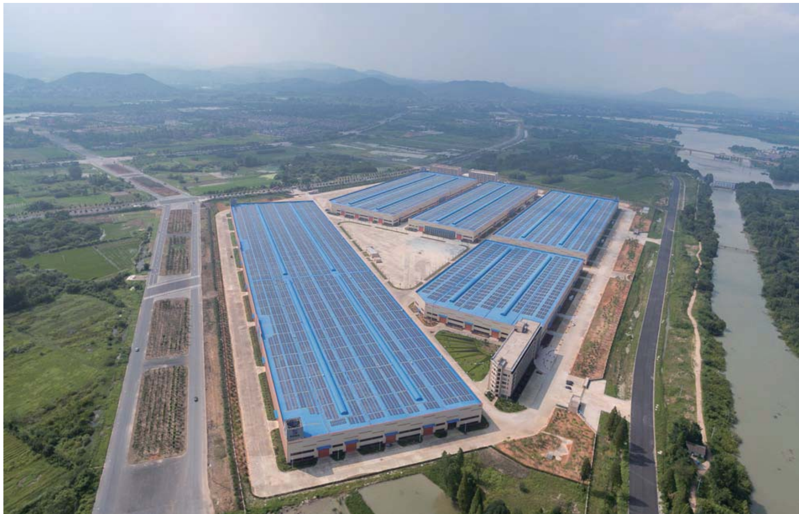
晶科科技浙江安吉13兆瓦屋顶光伏电站
