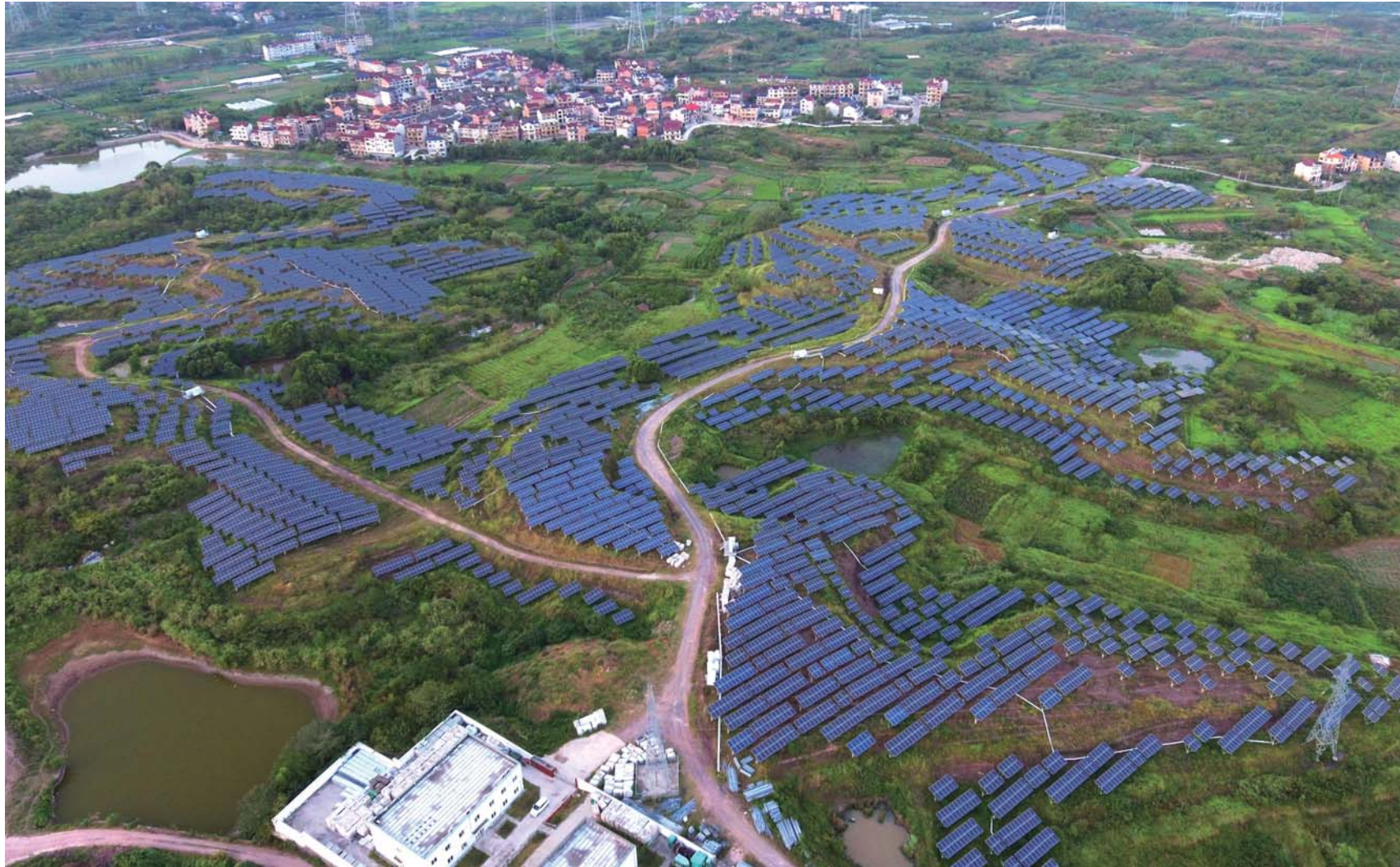
兰溪市梅江镇汪宅20兆瓦农光互补光伏发电项目
